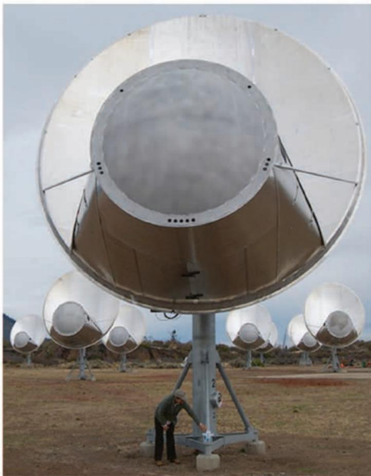
شکل ۱۰.۱۱ نمایی نزدیک از یکی از آنتن‌های تلسکوپ آلن که شامل تعدادی از صفحات به هم پیوسته است که هر کدام از آن‌ها ۵ متر اندازه دارد (کولبی گوتیرز- کریبیل)
